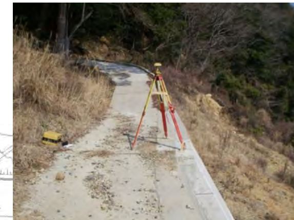
GPS-1 測定状況 (H25)
