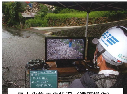
無人化施工の状況（遠隔操作）
