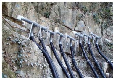
施工事例（上秋津：H30施工）
