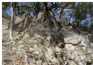
施工事例（上秋津：H30施工）
