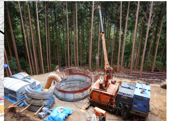
集水井工（地下水を排除するための井戸）
