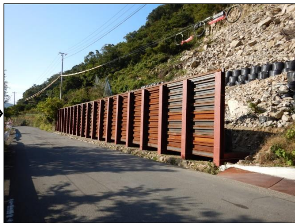
令和元年11月 防護柵（仮設）の設置
