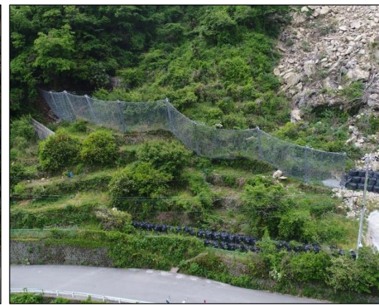
令和2年5月 落石防護柵の補修完了
