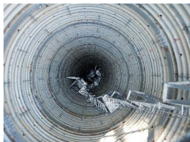
施工事例（上秋津：R2完成）
