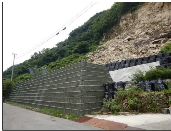
令和2年5月 擁壁（高さ5m）完成
