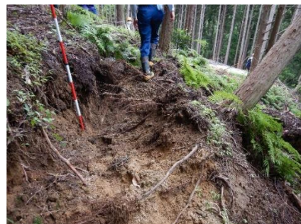
新たに発生した亀裂
