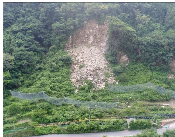
令和元年7月 拡大崩壊前
