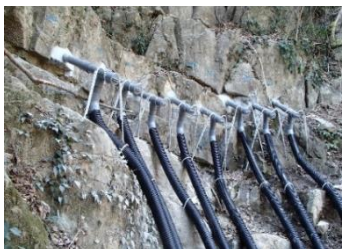
平成30年度完成の ボーリング暗きょ工
