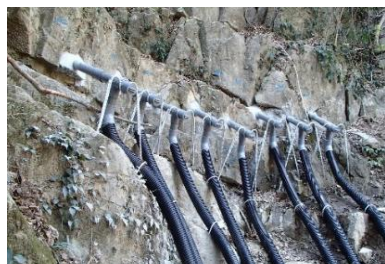
施工事例（上秋津：H30施工）
